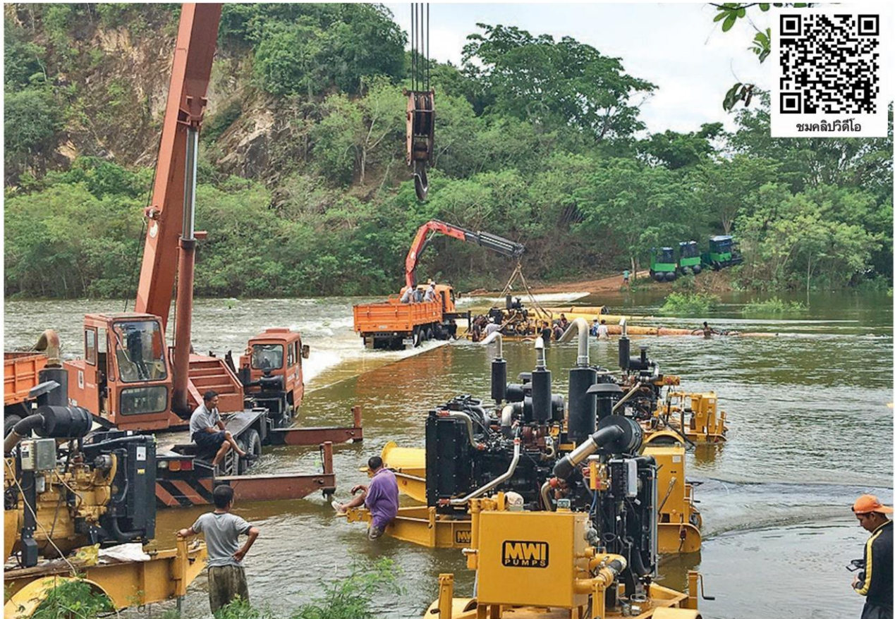
เร่งระบาย - เจ้าหน้าที่กรมชลประทานนำเครื่องสูบน้ำ 5 เครื่อง ไปวางบนสันดอนเหนือน้ำ บริเวณสปีลเวย์ เขื่อนแก่งกระจาน อ.แก่งกระจาน จ.เพชรบุรี เพื่อเร่งระบายน้ำ เมื่อวันที่ 7 สิงหาคม
