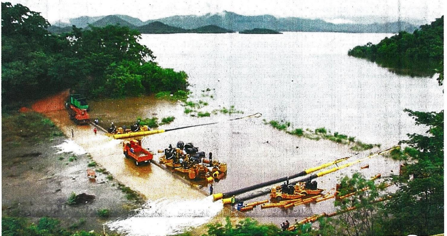
สนับสนุนโดย: ภาพมุมสูงบริเวณทางน้ำล้น (สปีลเวย์) เขื่อนแก่งกระจาน อ.แก่งกระจาน จ.เพชรบุรี มวลน้ำเพิ่มปริมาณอย่างรวดเร็ว ก่อนที่เจ้าหน้าที่จะติดตั้งเพิ่มท่อน้ำขนาดใหญ่ ช่วยระบายน้ำอีกช่องทาง พร้อมพร่องน้ำแม่น้ำเพชรบุรีทั้งช่วงเหนือและท้ายเขื่อนเพชรบุรี ออกสองข้างทางในคลองชลประทาน เพื่อสกัดไม่ให้น้ำไหลเข้าตัวเมืองในปริมาณที่สูงหรือเร็วเกินไป วานนี้ (6 ส.ค.) ภาพ: สำนักข่าวไทย
