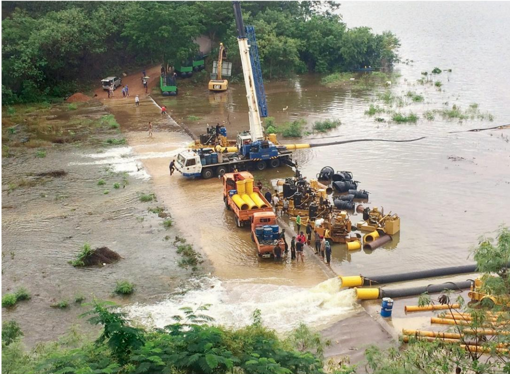
ล้นสปิลเวย์ - น้ำในเขื่อนแก่งกระจาน จ.เพชรบุรี เพิ่มความจุจนไหลล้นสปิลเวย์ เจ้าหน้าที่จึงรีบถอนท่อสูบน้ำขนาดใหญ่บางส่วนออกพร้อมเร่งติดตั้งท่อถักน้ำเพิ่มอีกนับสิบท่อ เร่งระบายน้ำลงเขื่อนเพชรเมื่อวันที่ 6 ส.ค.
