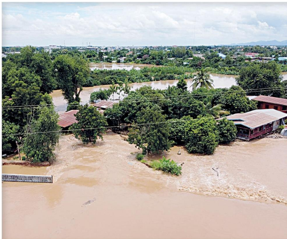
▲ พนักันแตก...ฝนถล่มอย่างหนักและต่อเนื่องในพื้นที่ภาคเหนือ กระแสน้ำกัดเซาะพนักันน้ำยมแตกไหลทะลักเข้าท่วมในหลายพื้นที่ของ จ.สุโขทัย เข้าขั้นวิกฤติ รถเล็กไม่สามารถสัญจรผ่านไปมาได้
