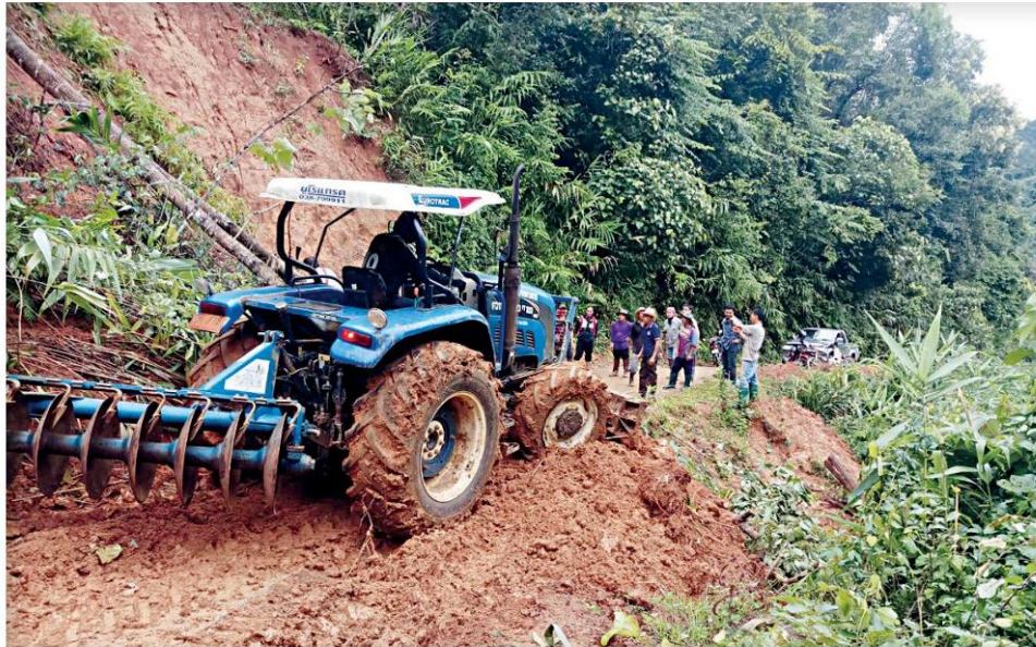
▲ ปิดถนน...จนท.นำรถไถดินที่สไลด์ลงมาจากภูเขาออกจากถนน เพื่อเปิดเส้นทางการจราจร หลัง จากเกิดฝนตกหนักต่อเนื่อง จนเกิดดินสไลด์ทับปิดเส้นทางในพื้นที่ ต.ป่าแป๋ อ.แม่สะเรียง จ.แม่ฮ่องสอน
