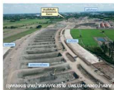
(ดูคลองระบายน้ำปากลากก่อสร้าง ปตร.ปลายคลองน้ำหลาก)
