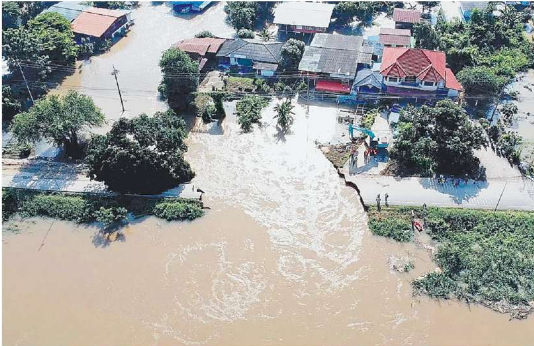
ถนนขาด ภาพมุมสูงความเสียหายถนนคันคลองมหาธาร จ.ตลิ่งชัน อ.สรรพยา จ.ชัยนาท เป็นพื้นที่เขตติดต่อกับ ต.หนองหม้อ อ.ตาคลี จ.นครสวรรค์ ถูกน้ำกัดเซาะถนนขาดกว่า 50 เมตร เจ้าหน้าที่ปิดการจราจรแจ้งชาวบ้านใช้ทางเลี่ยง มวลน้ำไหลลงคลองมหาธารใกล้จะล้นตลิ่งเข้าท่วมบ้านเรือน ประกาศแจ้งให้ชาวบ้านเฝ้าระวังและขนทรัพย์สินขึ้นที่สูง.
