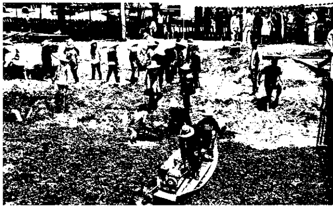
▲ กิจกรรมการจ้างแรงงานชลประทานสร้างรายได้ให้เกษตรกร ปรับปรุงพื้นที่อ่างเก็บน้ำกุดสิงห์ อ.นาดูน จ.อุดรธานี
